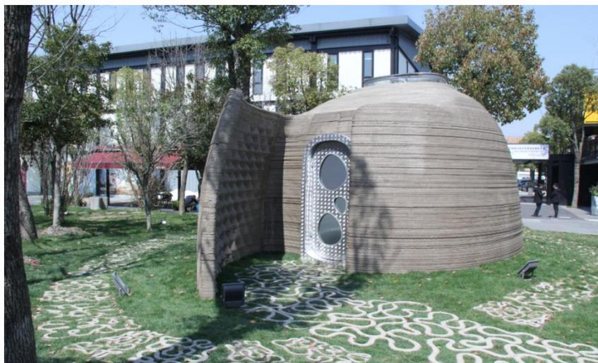
该书屋的设计建造表明，3D 打印作为智能建造的一种方式，不仅节省材料、节省人力，同时建造效率高、施工速度快，并且可以实现不规则形状的建筑建造、保证高质量的建筑品质。
